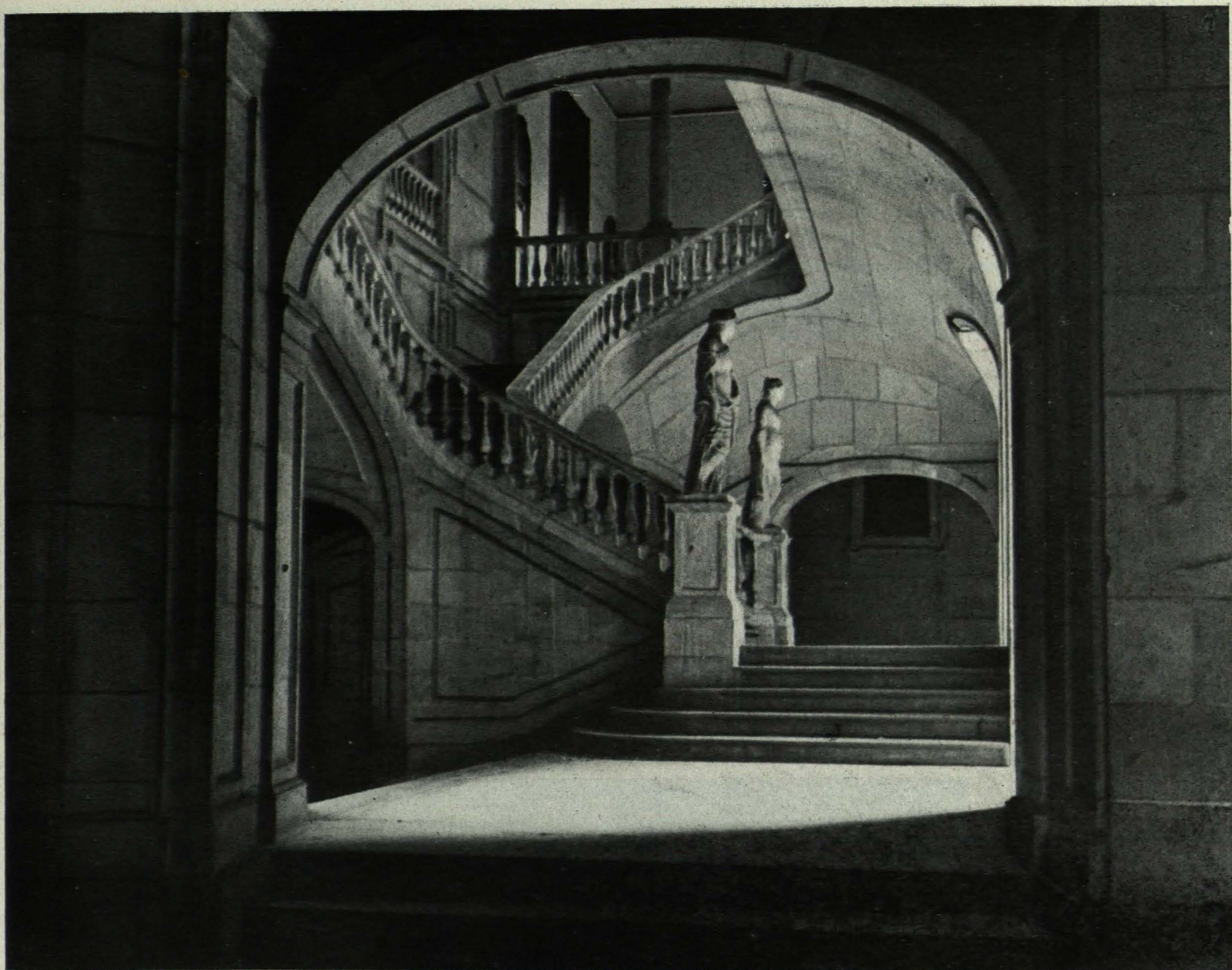
Lonja de Mar. Escalera de Honor. Nótese la atrevida bóveda, de complicada estereotomía, traducción en piedra de las bóvedas tabicadas usuales en Cataluña.
