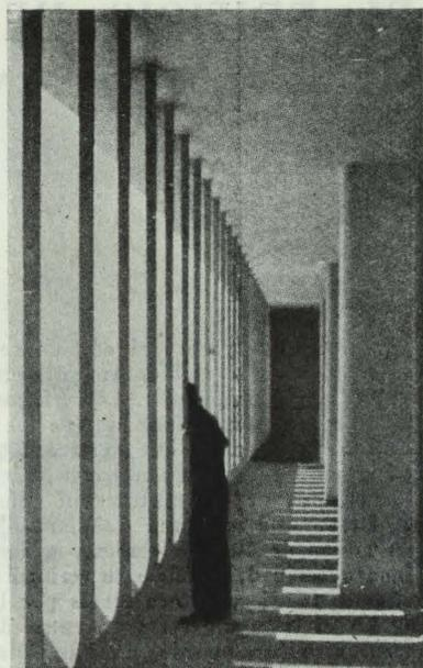
*Paisaje a vista de mula: Un hombre trata de atisbar el mundo exterior a través de las orejeras de un «brise-soleil» de láminas fijas. Sin embargo, hay que reconocer que, si se dirigen de un modo conveniente las placas de hormigón, puede evitarse que se vea el nuevo edificio de la foto de la izquierda, lo que ya justificaría el «brise-soleil» en este caso.*
