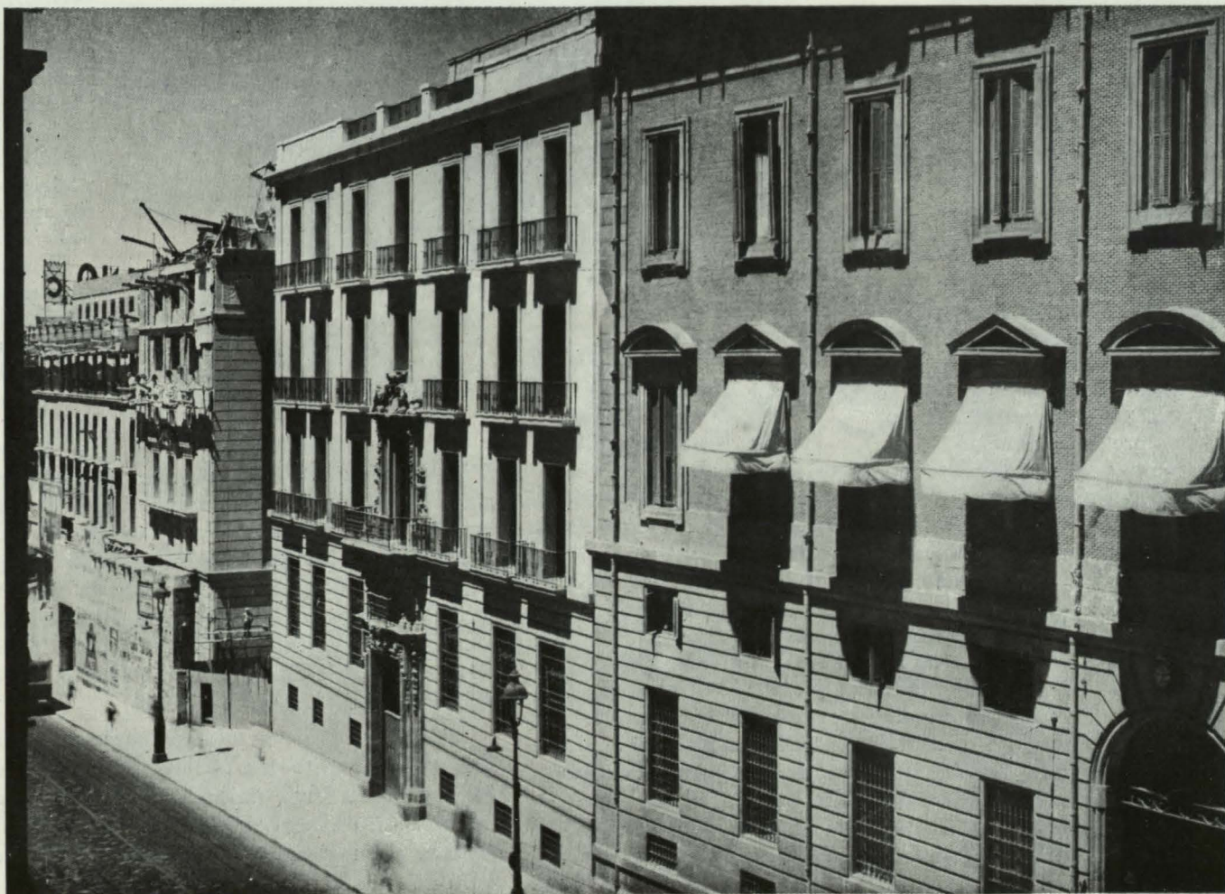
Restauración del Ministerio de Hacienda y ampliación con el edificio de nueva planta. Madrid. Arqui- tecto, Miguel Durán.
