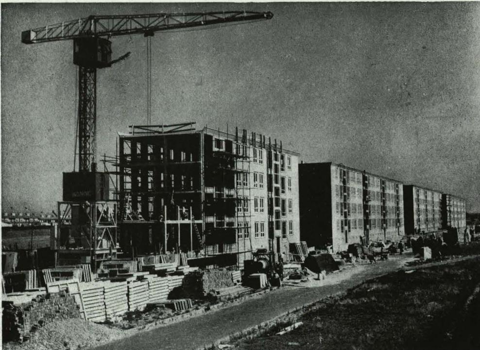
*Construcción de casas prefabricadas en Rotterdam, donde por primera vez en Holanda se utilizó este sistema. Las vigas de hormigón, las fachadas, los forjados de piso, son colocados mediante una grúa especial, para proceder a su montaje.*
