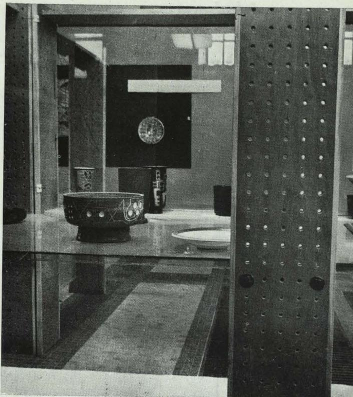
Se trata de dos tipos de elementos de madera, en los que, mediante una serie de perforaciones, se ha conseguido obtener su acoplamiento en el sentido paralelo y en el perpendicular, con todas las aplicaciones que de este hecho se derivan.
