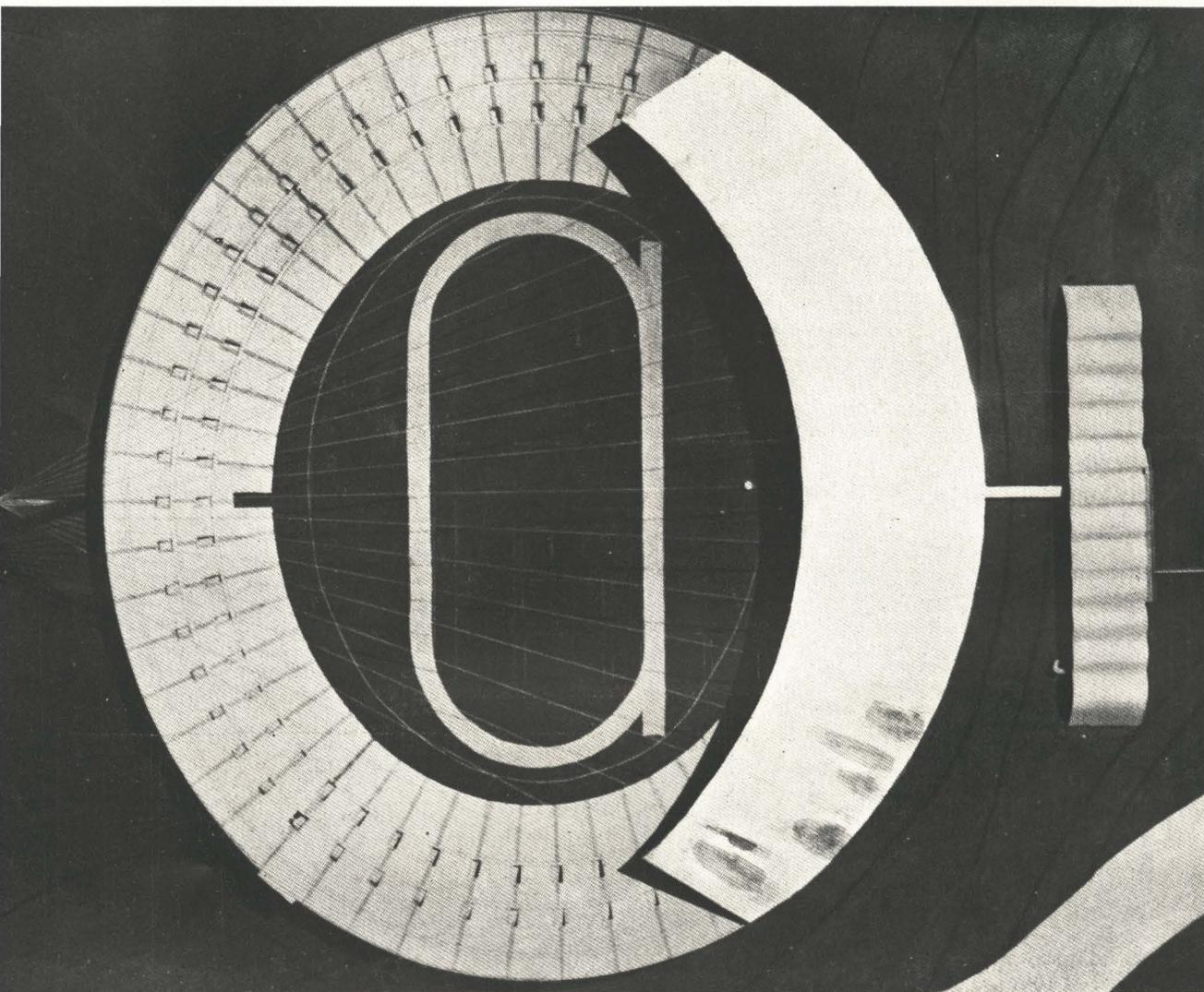
*Este Estadio tiene una capacidad de 125.000 espectadores, de los cuales 30.000 están sentados y cubiertos, 20.000 cubiertos y de pie y 75.000 de pie. La rigidez de los anillos de hormigón se asegura por una armadura de hierro formada por tirantes distribuidos a lo largo de la estructura exterior.*
