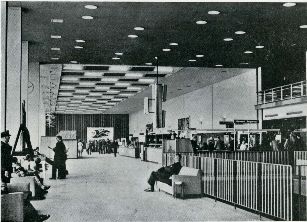
Vestibulo principal en el edificio de pasajeros.
