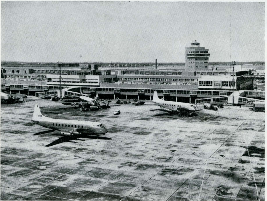
Vista general de los edificios desde la "zona de aire". Al fondo, el edificio de control.
