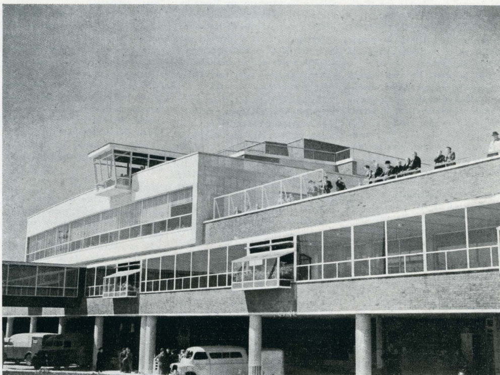
Fachada en la "zona de aire" del edificio de pasajeros. A la izquierda, el pasadizo que conduce a los aviones.
