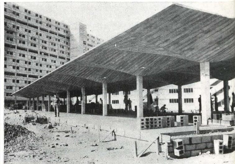
y las medianas a sus bordes inclinados, que se confunden dos a dos y forman cuatro aristas. El encofrado se obtiene situando dos listones a lo largo de la mediana situada entre ellos. Las tablas que se apoyan sobre dichos listones, en dirección normal a ellos, producen automáticamente la bóveda.
