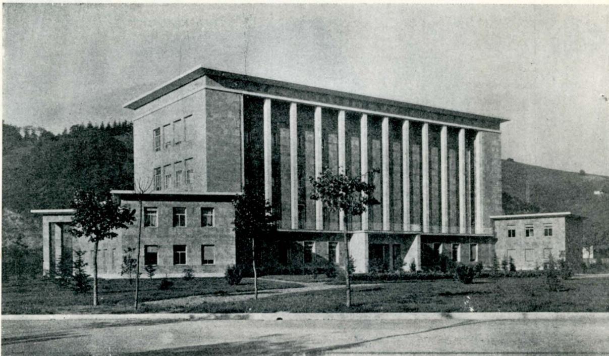
Fachada principal a la plaza.
