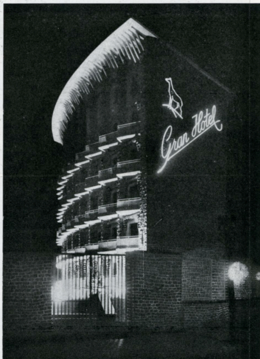
Vista de la fachada, de noche.
