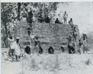
Preparación de un horno de ladrillos.
