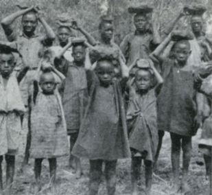
Estos son los "sillares" que servirán para construir la capilla.
