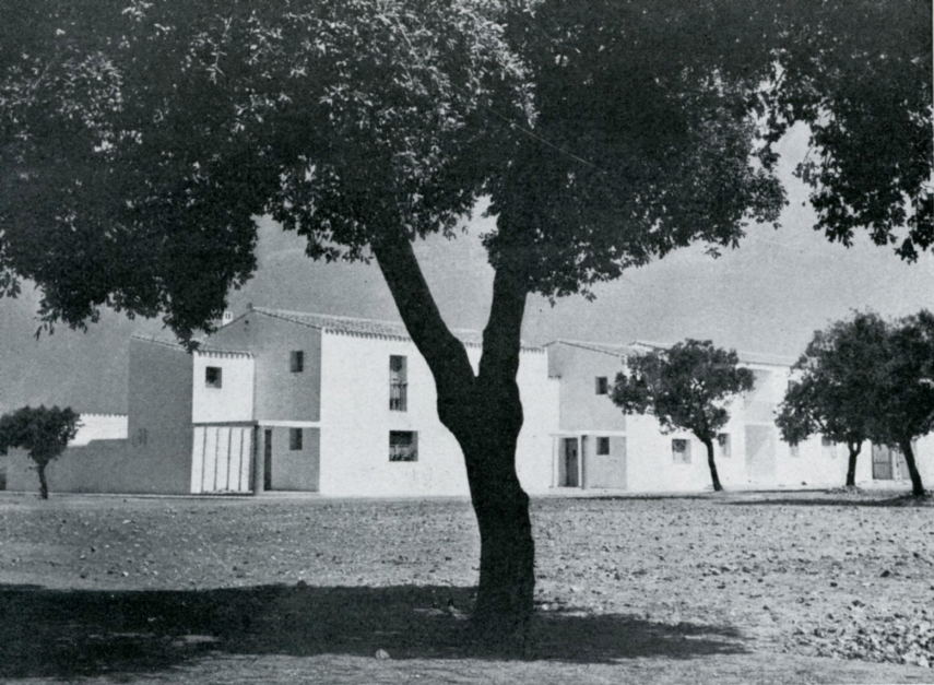
Viviendas de maestros.
