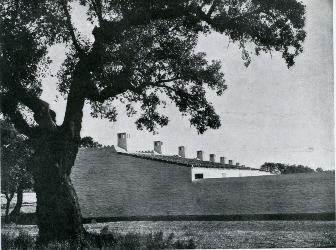
Aspectos de cerramientos
