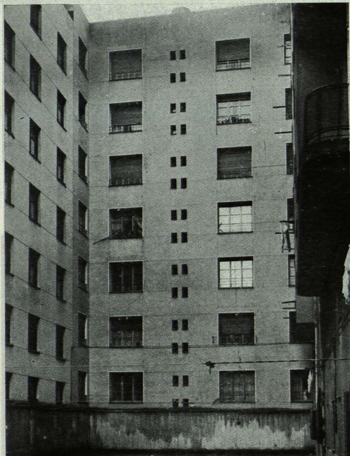
Fachada posterior a patio de manzana.
