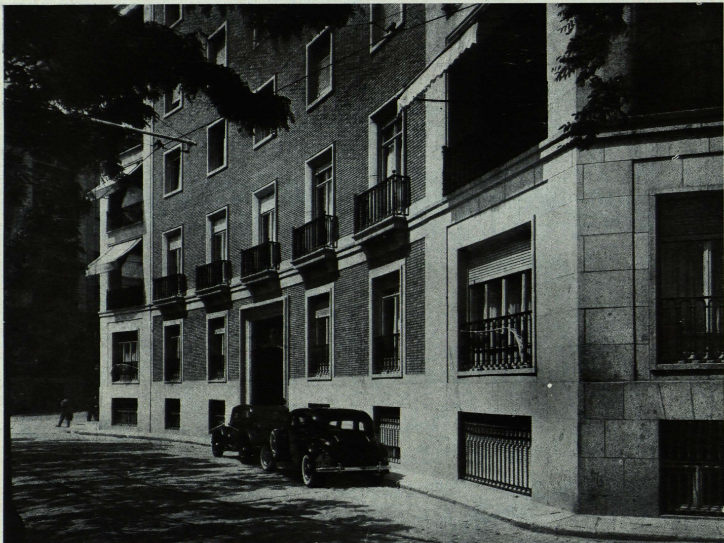
Detalle de fachada
