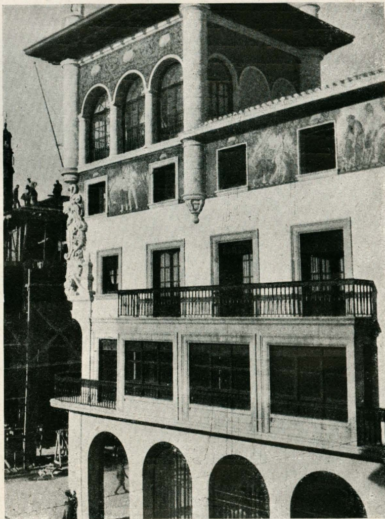
Detalle de fachada
