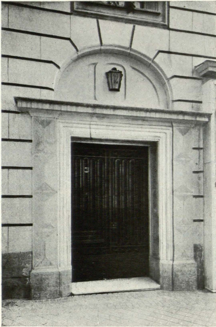
Puerta de ingreso
