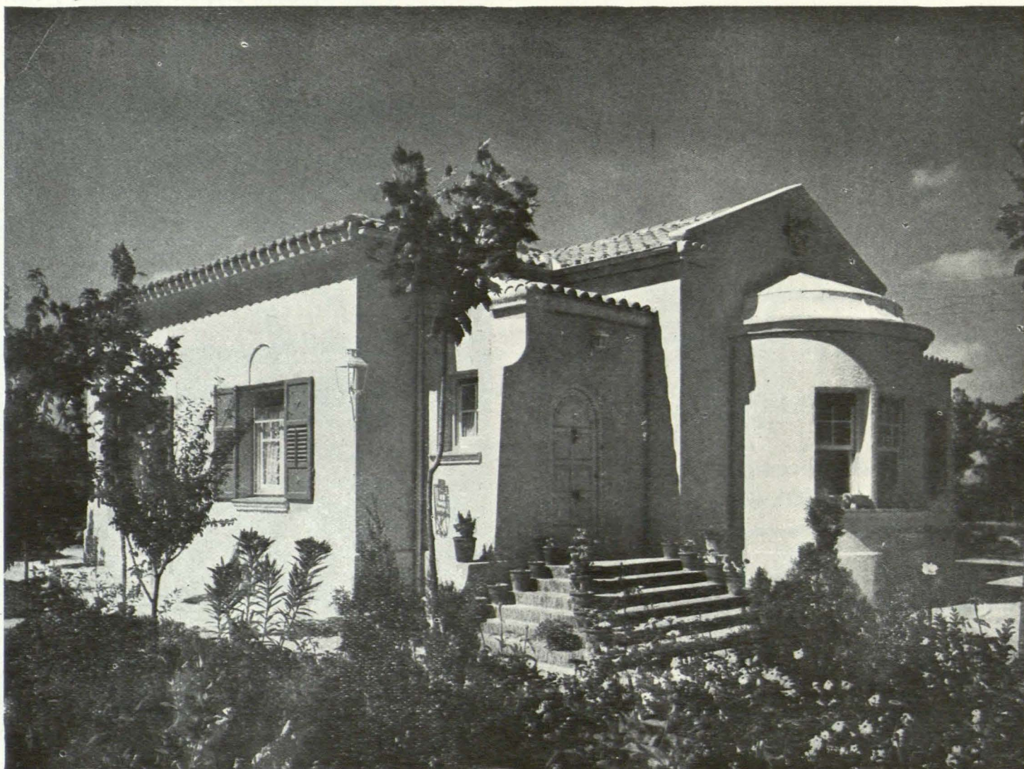
Fachadas principal y lateral
