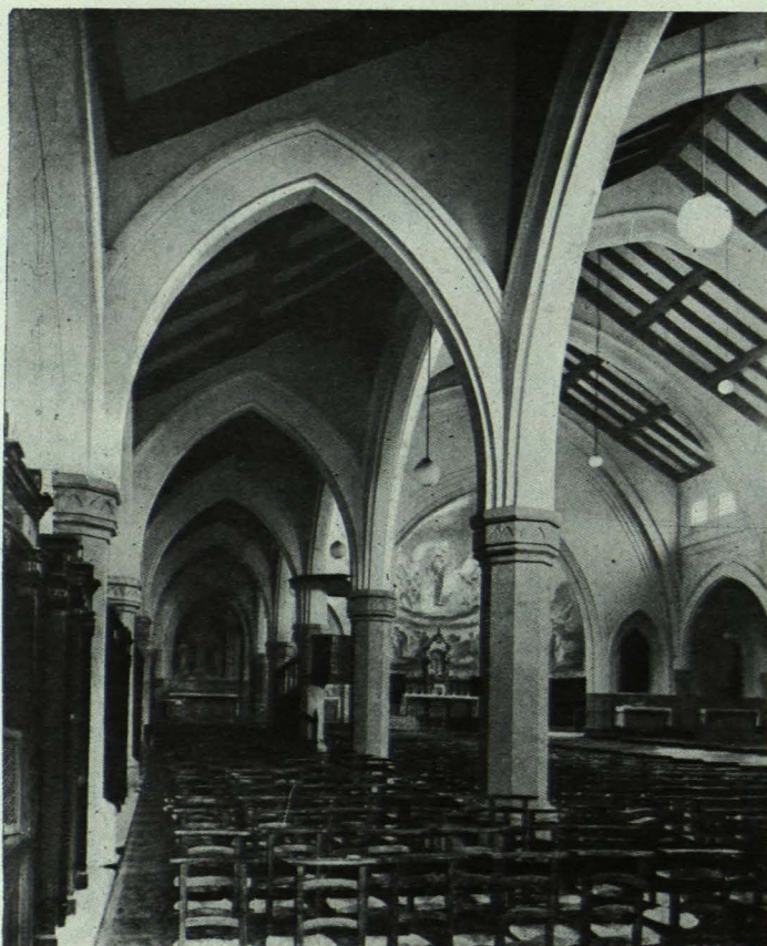
Parroquia de "San José" (Baracaldo-Bilbao). Vista interior:
