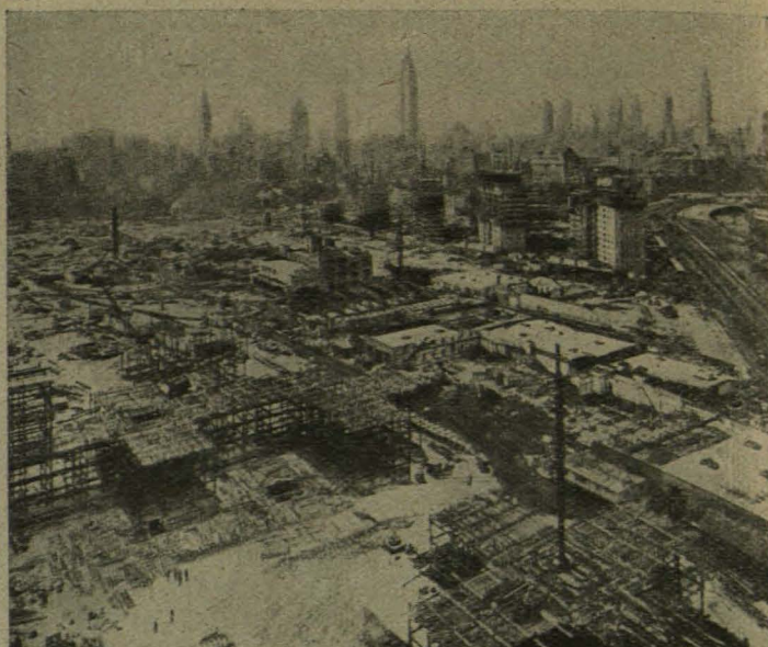
Obras de "Peter Cooper Village". En primer plano se ve cómo se levanta la estructura metálica de uno de los edificios de "Stuyvesant Town"
