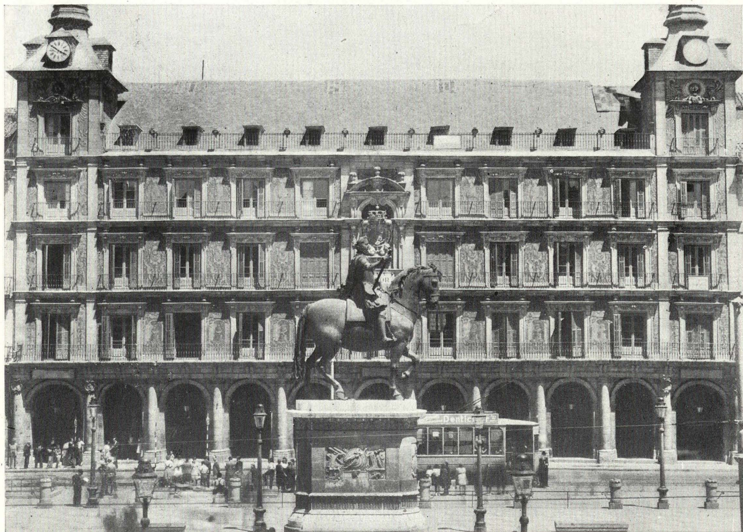
Casa Panadería en su estado actual.
