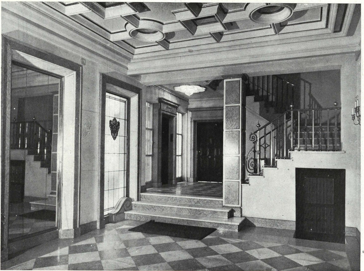
Arranque de la escalera que conduce a las viviendas.
