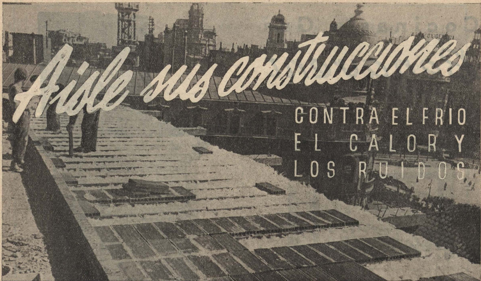
Aislamiento térmico de terrazas en un edificio en construcción. - Valencia. - Arquitecto Don Joaquín Rieta
