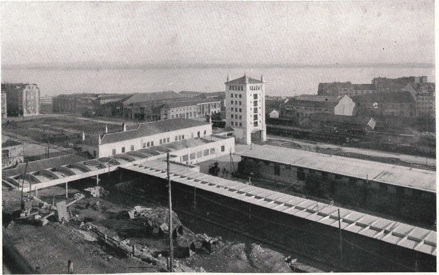
Vista de las estaciones durante las obras.
