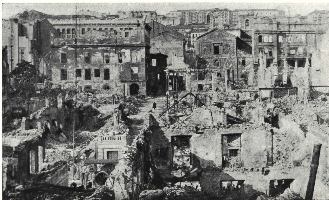
Otro aspecto de la zona destruída por el incendio.
