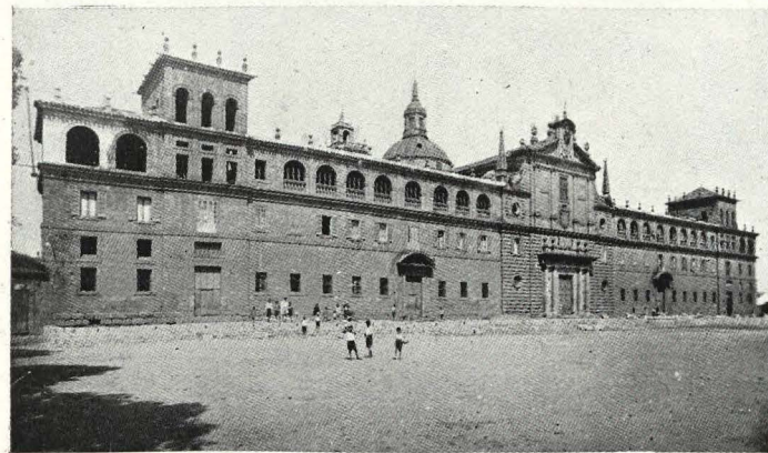
Colegio de Escolapios de Monforte de Lemos. Proyecto de Juan de Tolosa, S. J. (1593), y construido por los trasmeranos Diego de Isla, Cajigas, Vélez, Güemes, y otros.
