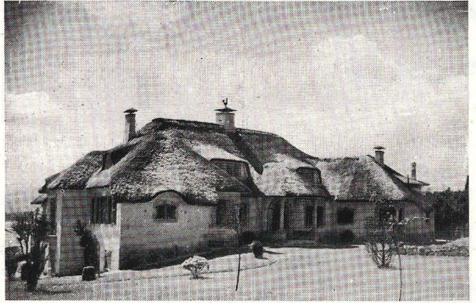
Fachadas Norte y Oeste.
