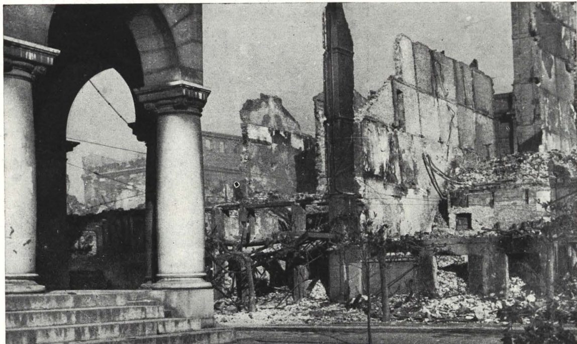
Un aspecto de la zona destruída.
