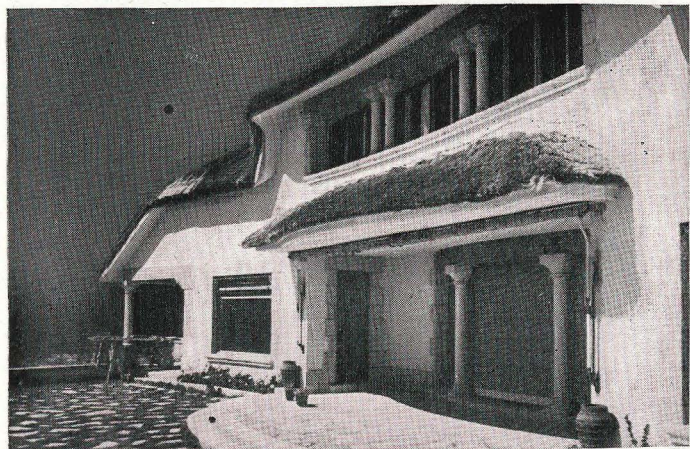
Detalle parcial de la fachada Sur.
