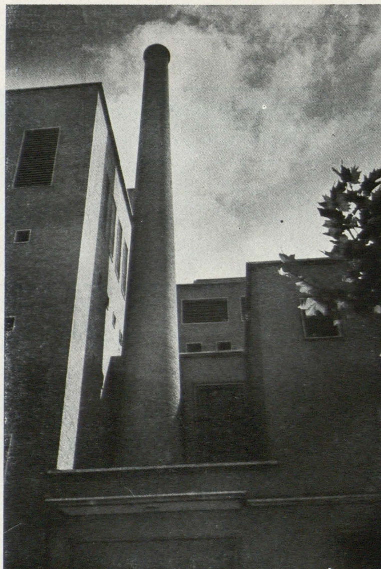
Chimenea del generador de vapor.
