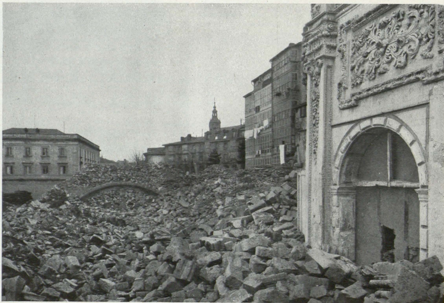
Interior de la nave del templo de San Francisco después del derribo.
