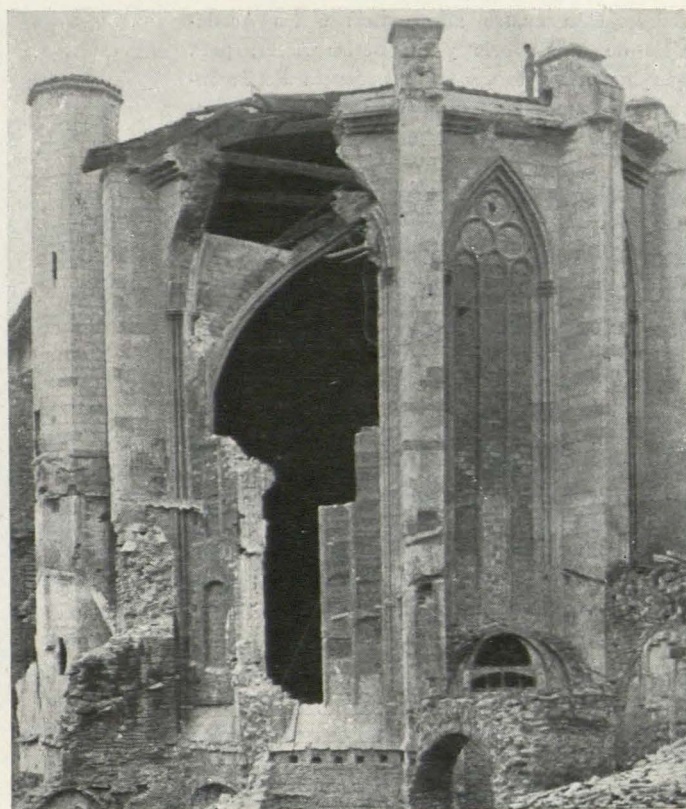
El ábside, iniciado su derribo.
