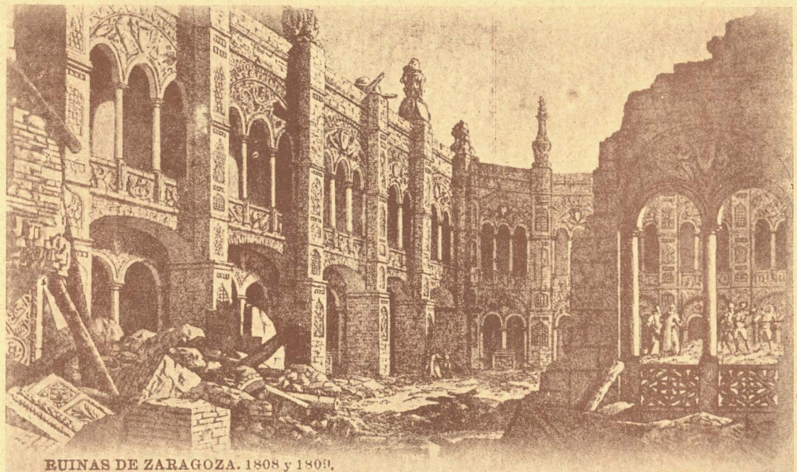
RUINAS DE ZARAGOZA. 1808 y 1809.
