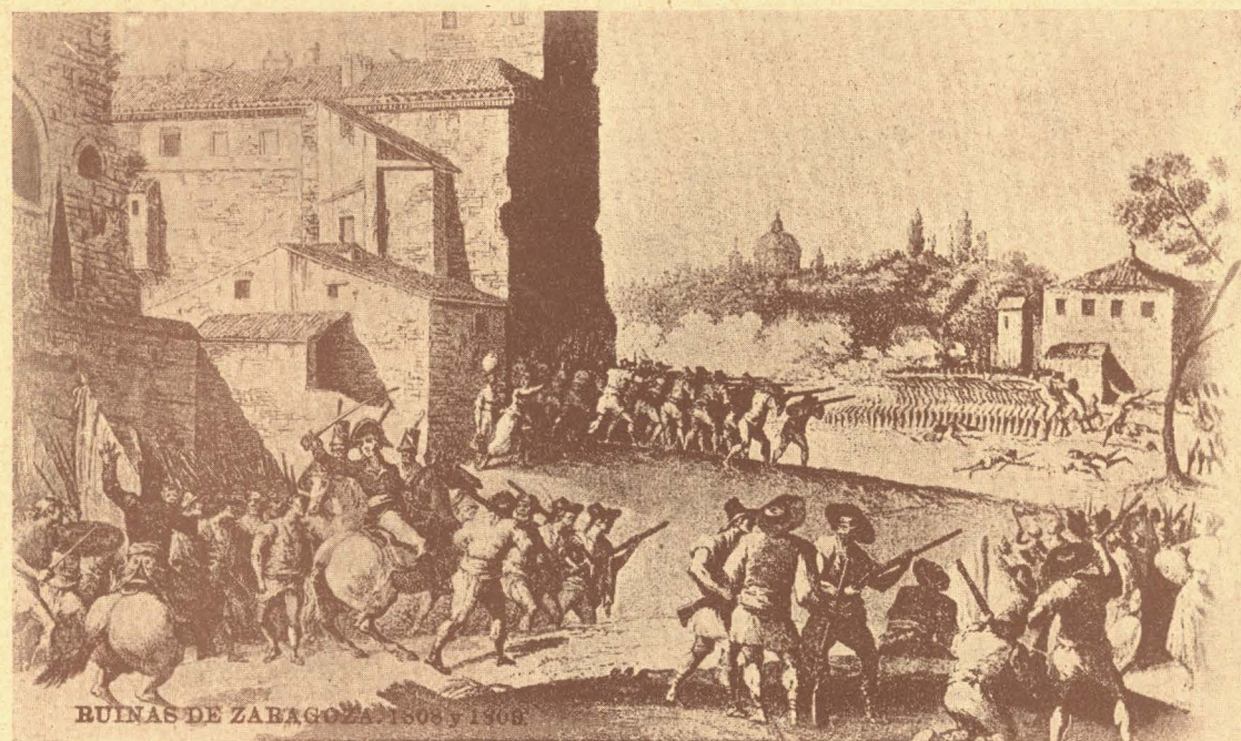
RUINAS DE ZARAGOZA. 1808 y 1809.
