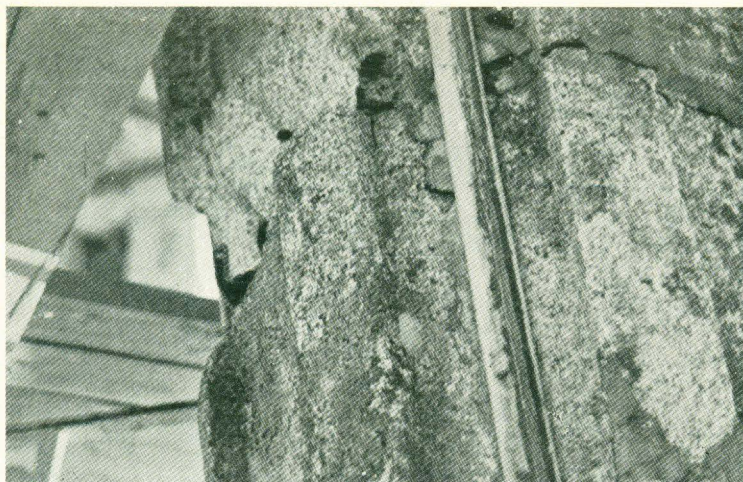
Rotura de las piedras de la aguja del cimborrio. Abajo: Croquis de la disposición empleada para elevación de las piedras nuevas.
