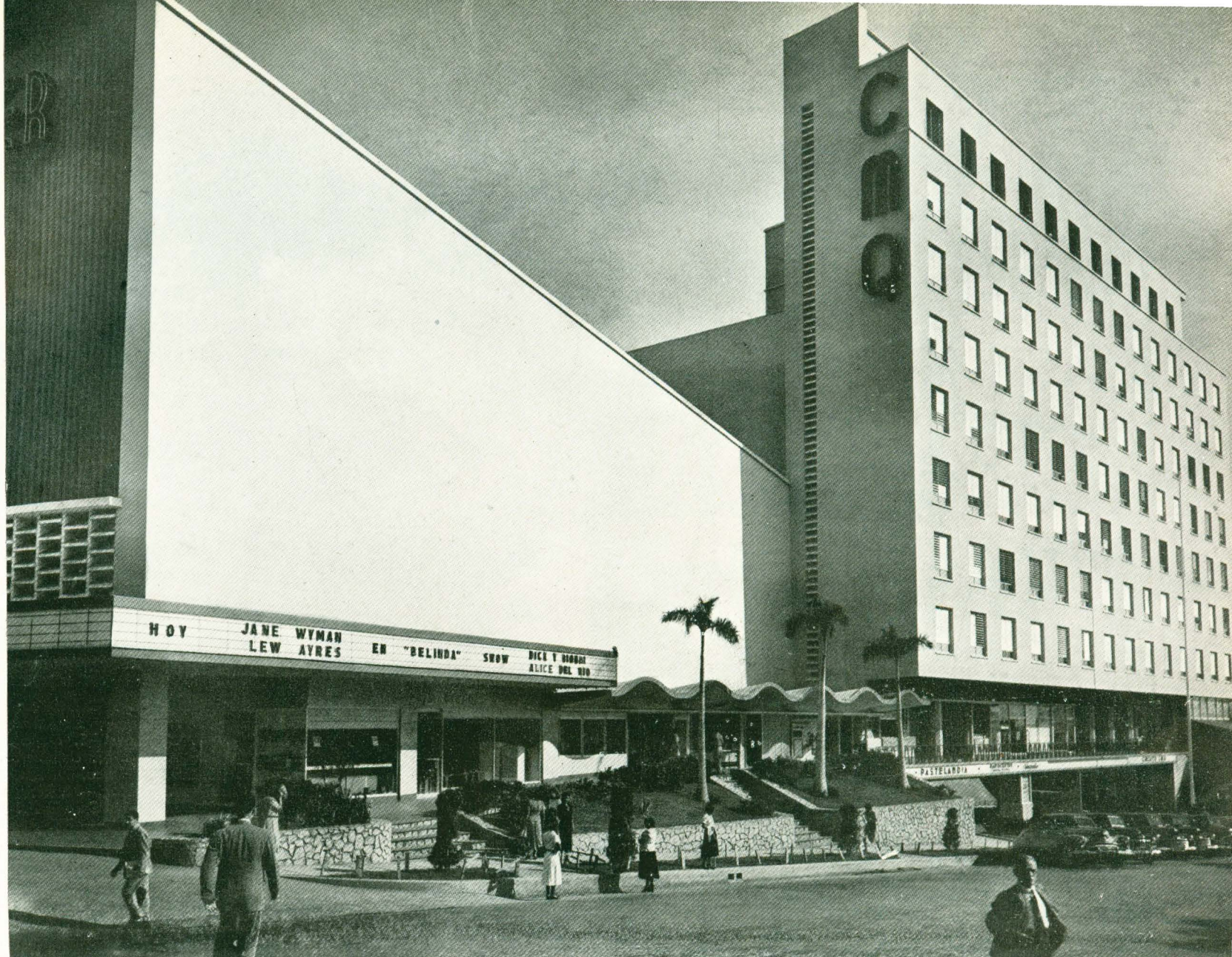
Conjunto del edificio Radio Centro, en La Habana.
