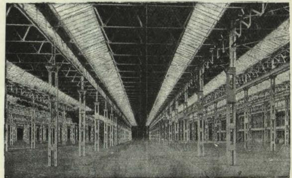
Cubiertas y claraboyas de cristal con barras de acero de perfil especial enfundadas en plomo
