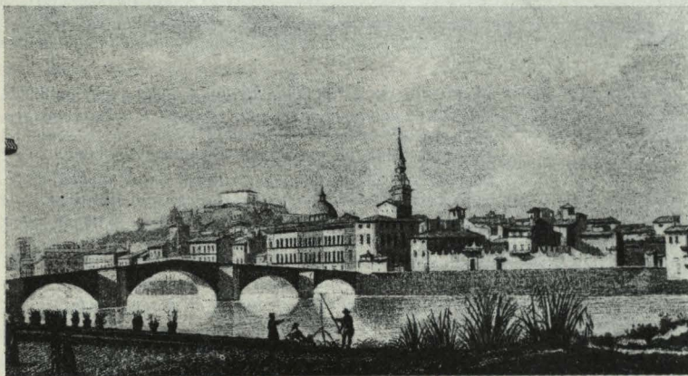
Vista del Puente alla Carraia.
