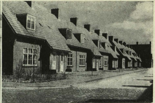
Viviendas obreras. Construcción tradicional holandesa con fábrica de ladrillo.
