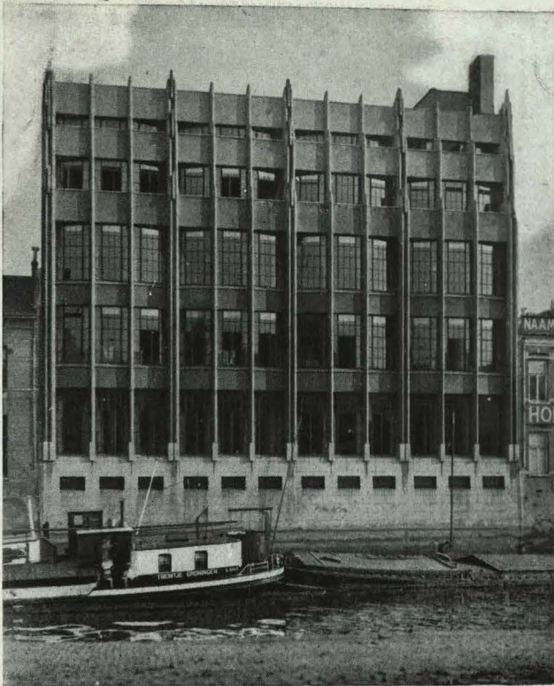
El primitivo edificio, también del arquitecto Mertens, que fué destruído totalmente durante la última guerra. En la fotografía inferior, el Banco actual, notablemente ampliado.
