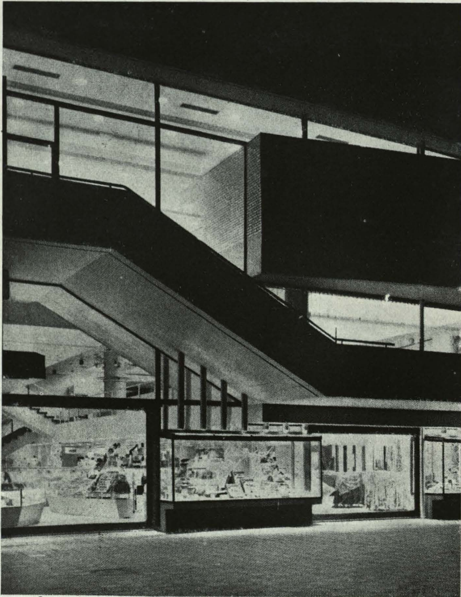
Vista de la fachada con la escalera durante la noche.
