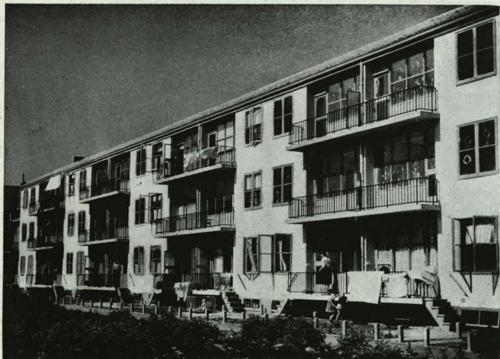
Viviendas de construcción sistemática en Rotterdam Overschie.
