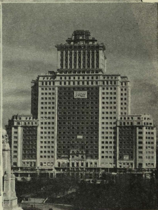
Edificio de la Inmobiliaria Metropolitana en la plaza de España, Madrid, en cuyo aislamiento de terrazas, tabiques, etc., se han empleado 12.450 m. c. de VITROFIB, Fibra de Vidrio.
