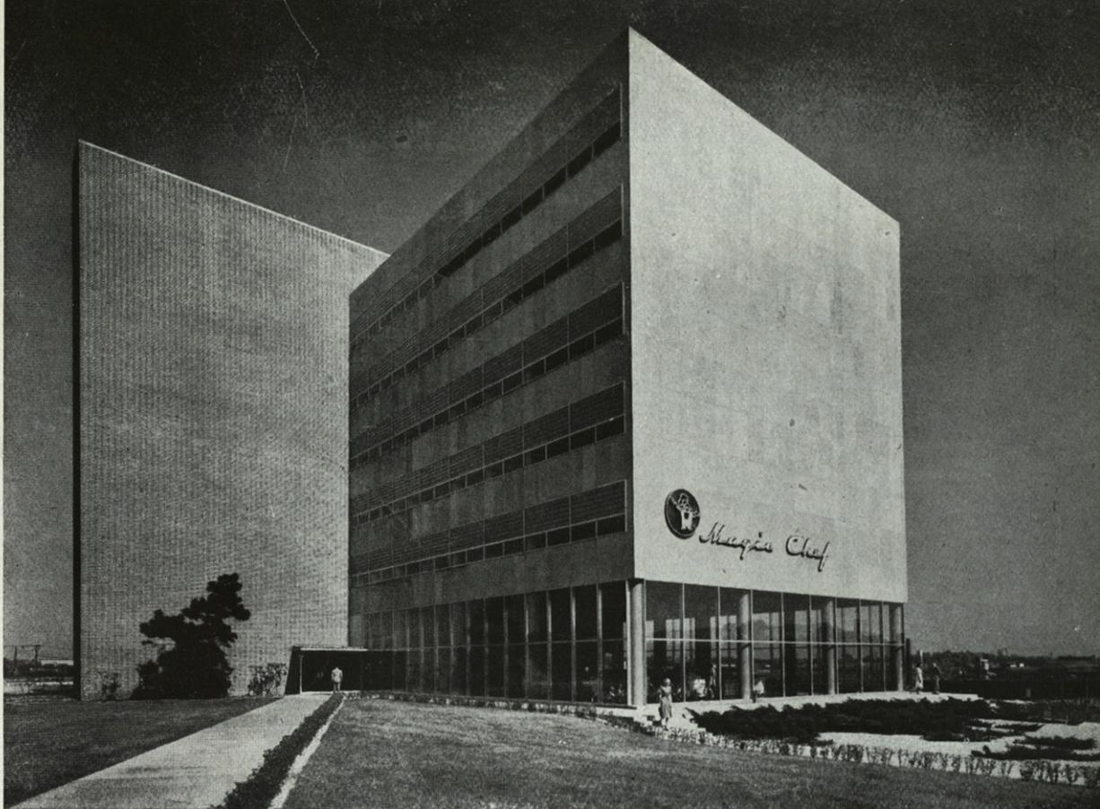
Fotografías del edificio de la American Stove, en las que se observan las características de construcción. En las fachadas orientadas a Este y Oeste, se prescindió en absoluto de ventanas, para evitar los malos efectos del sol bajo sobre el horizonte. La fachada Norte, toda ella abierta con grandes ventanales transparentes. La fachada Sur, con ventanales formados por dos fajas de cristal: la inferior transparente y la superior de aldososa direccional traslúcida.
