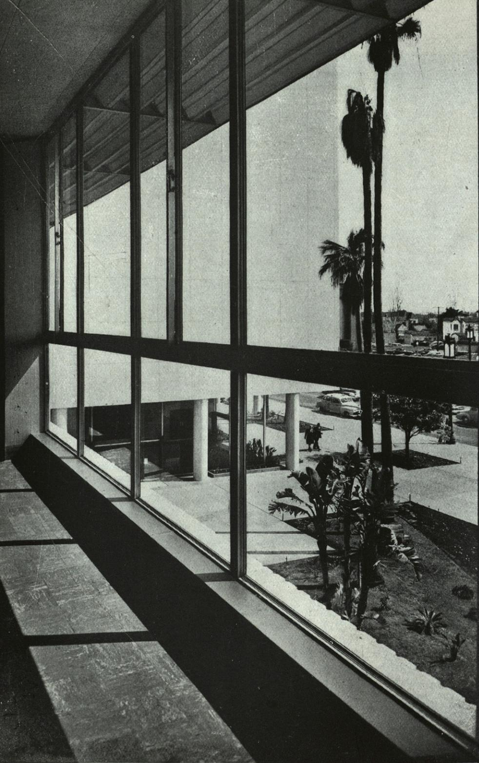
*Una ya típica aplicación de viseras para la protección de las superficies vidriadas frente a la excesiva irradiación solar de verano. Visera abierta para permitir la circulación vertical del aire caldeado ante la ventana.*
