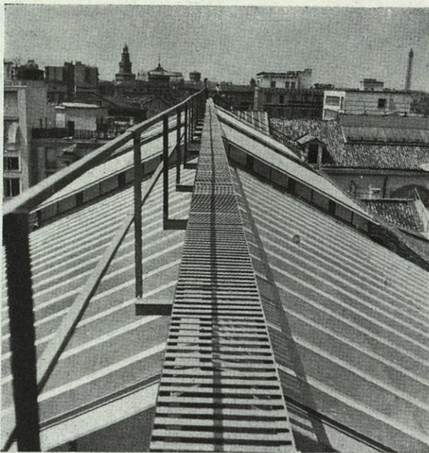
satinado al ácido por las dos caras, de un espesor de 10/12, alisados en las uniones para formar una superficie ópticamente continua.
