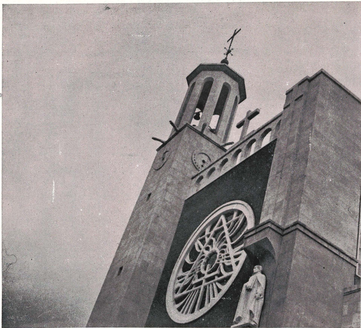
Pormenor de la fachada principal con el gran rosetón de hormigón armado.
