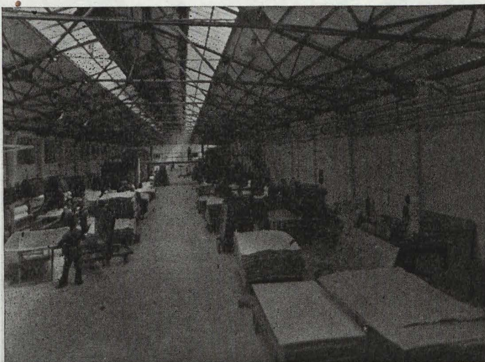
Nave de armado y encolado.
