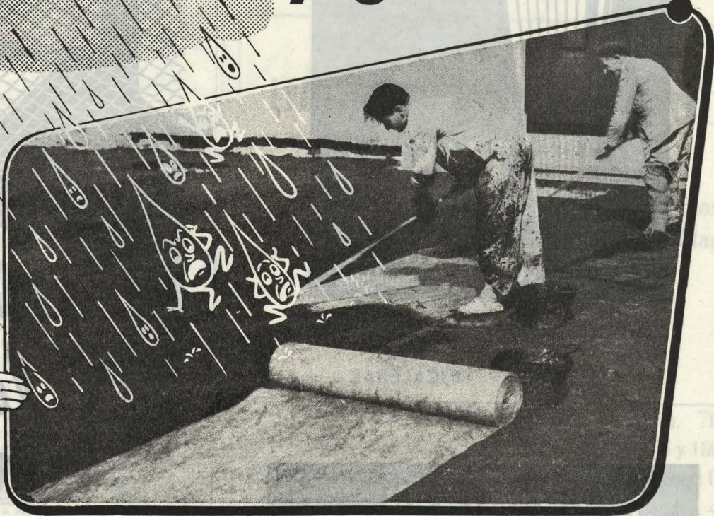
Detalle de la impregnación con emulsión asfáltica del VELO VITROFIB, en una terraza de la Basílica de Atocha, Madrid.
