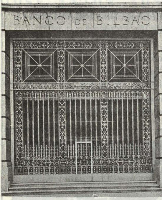
Puerta tipo guillotina de accionamiento electro-mecánico
