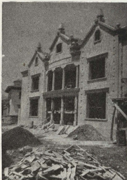
Chalet en Tenerife. Proyecto: arquitecto M. Fernández de la Torre.
