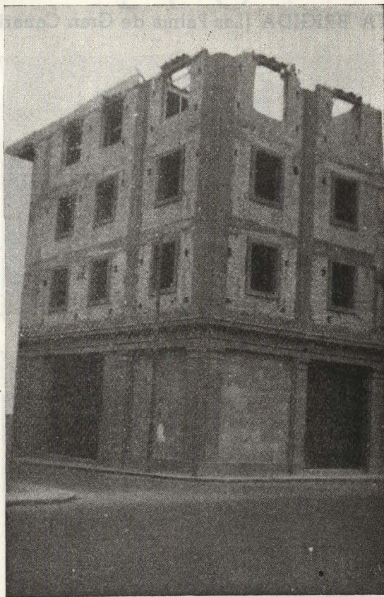
Obra en construcción para fábrica de productos alimenticios
