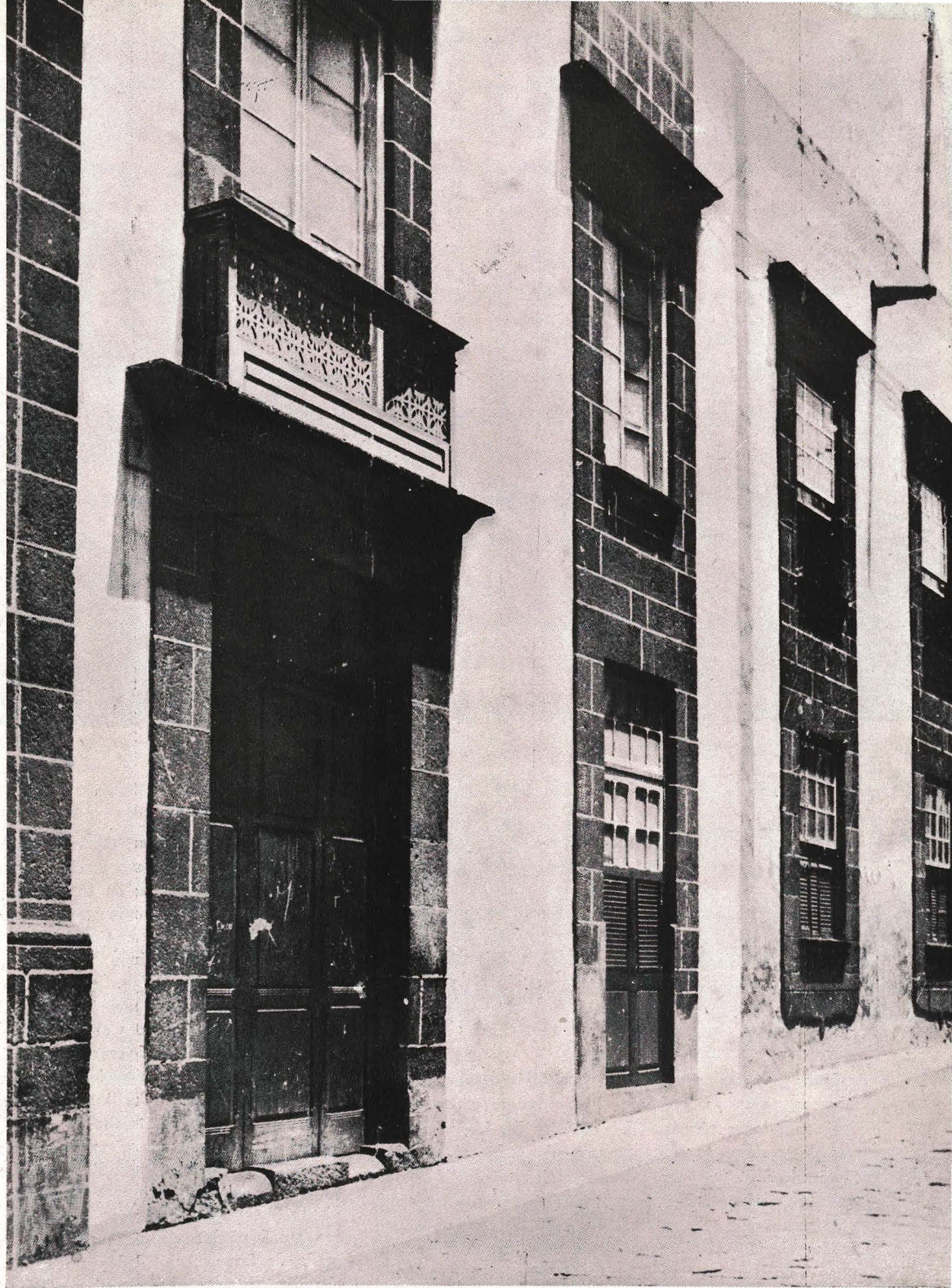
Casa en la calle López Botas, Las Palmas. Se aprecia en estos dos ejemplos una de las características más acusadas en la arquitectura urbana canaria: la verticalidad.
