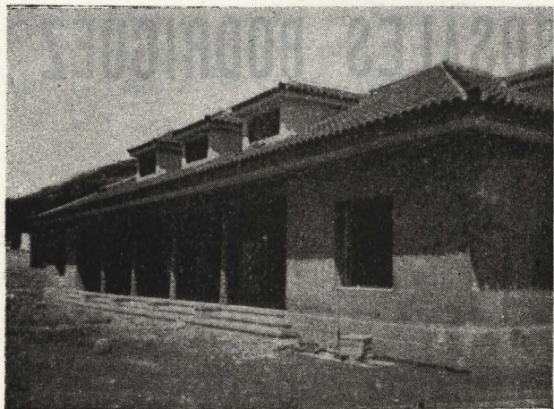
Chalet en construcción en Tenerife. (Proyecto. Arquitecto: Sr. Marrero).
