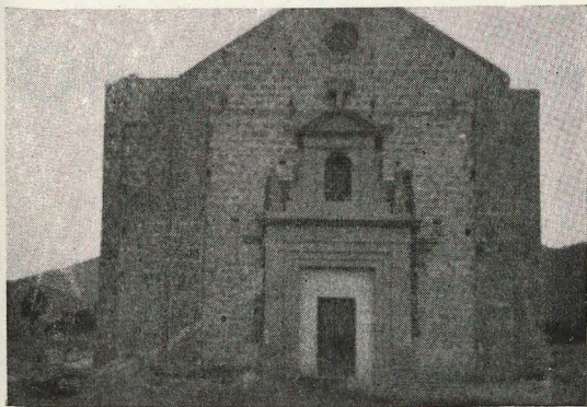
Iglesia del Monte en construcción
