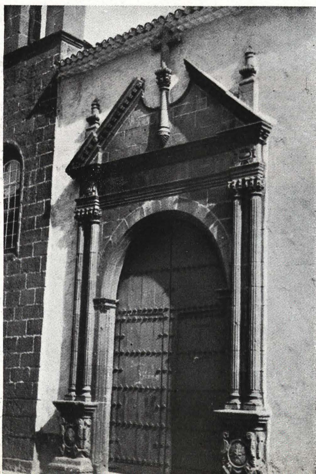
Portada de la iglesia del Hospital Civil, de La Laguna.
