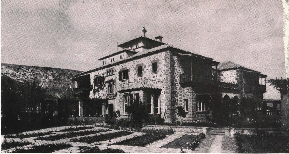
Edificio del Alto Estado Mayor del Aire.
