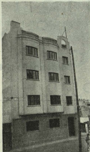
EDIFICIO EN LAS PALMAS Contratista: Andrés Sánchez Medina
