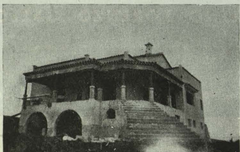
Hotel en construcción, por Andrés Sánchez Medina, en Monte Coello (Santa Brígida)
