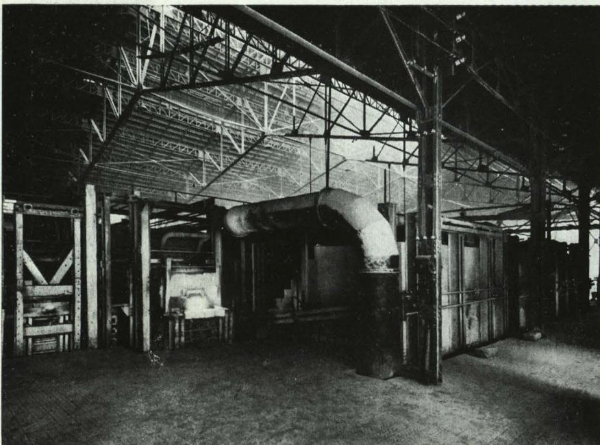
*Vista parcial y lateral del nuevo horno, el de mayor capacidad de España, con detalle de las cámaras de recuperación en toda su longitud. En primer término, la gran tubería para la ventilación de los quemadores.*
