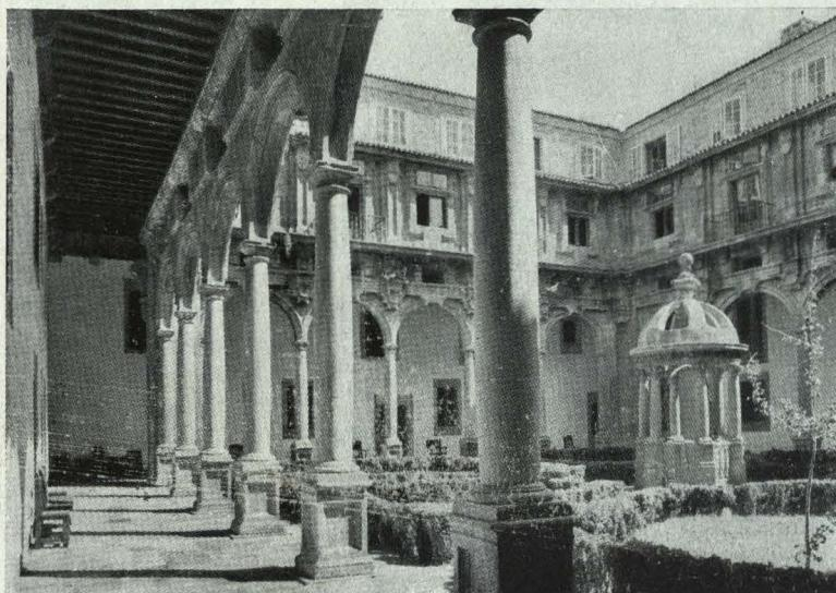
Uno de los dos patios barrocos, que se vació totalmente, en una profundidad de 6 m., para instalar debajo la Sala de Máquinas y Calderas. Encima de la losa de hormigón, que constituye el piso, se ha plantado un jardín. La Sala de Máquinas se ventila por el templete central. La planta alta, que se observa en la fotografía y que estaba incompleta, es totalmente nueva.
