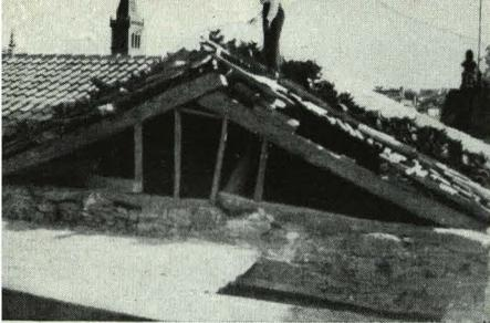
Uno de los muchos modelos de armadura de la cubierta existente. Su empuje sobre los muros había producido considerables desplomes.
