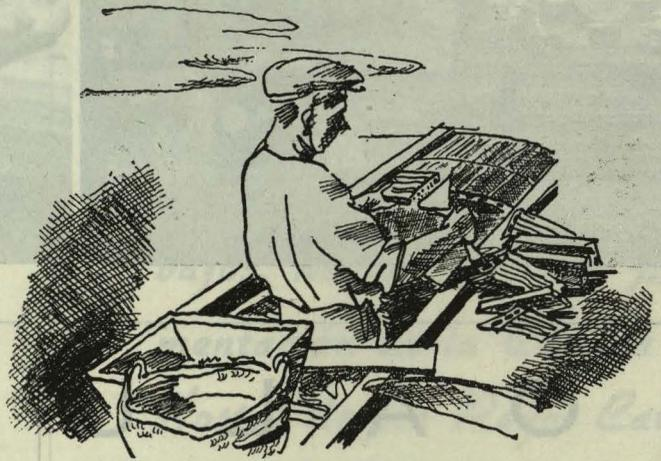
*La gabera metálica corrediza para muros de hormigón.*
