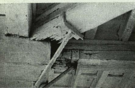
Los forjados horizontales eran todos de madera, la mayoría podridos y carcomidos. Estado de las vigas de un ángulo de un patio gótico y "sistema" empleado para sostenerlas.
