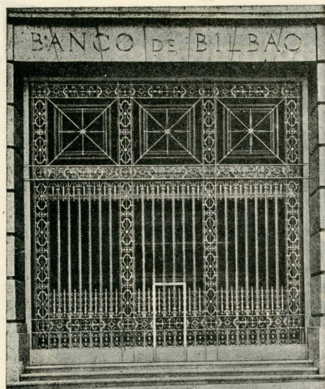
Puerta tipo guillotina de accionamiento electro-mecánico
