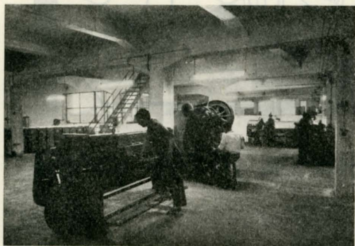
← Aspecto parcial de las instalaciones inauguradas.
