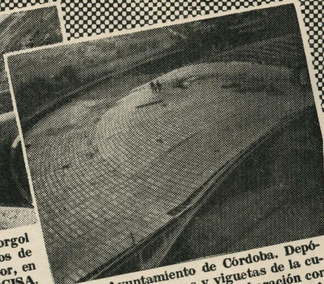
Excmo. Ayuntamiento de Córdoba. Depósito de agua. Placas y viguetas de la cubierta, en colaboración con FABREGA, S. A.
