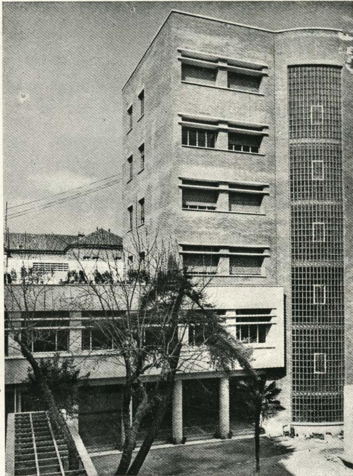
FACHADA INTERIOR EN EL PATIO AÚN NO TERMINADO.—Las pantallas de hormigón impiden la incidencia directa del rayo del sol de mediodía en las clases.
