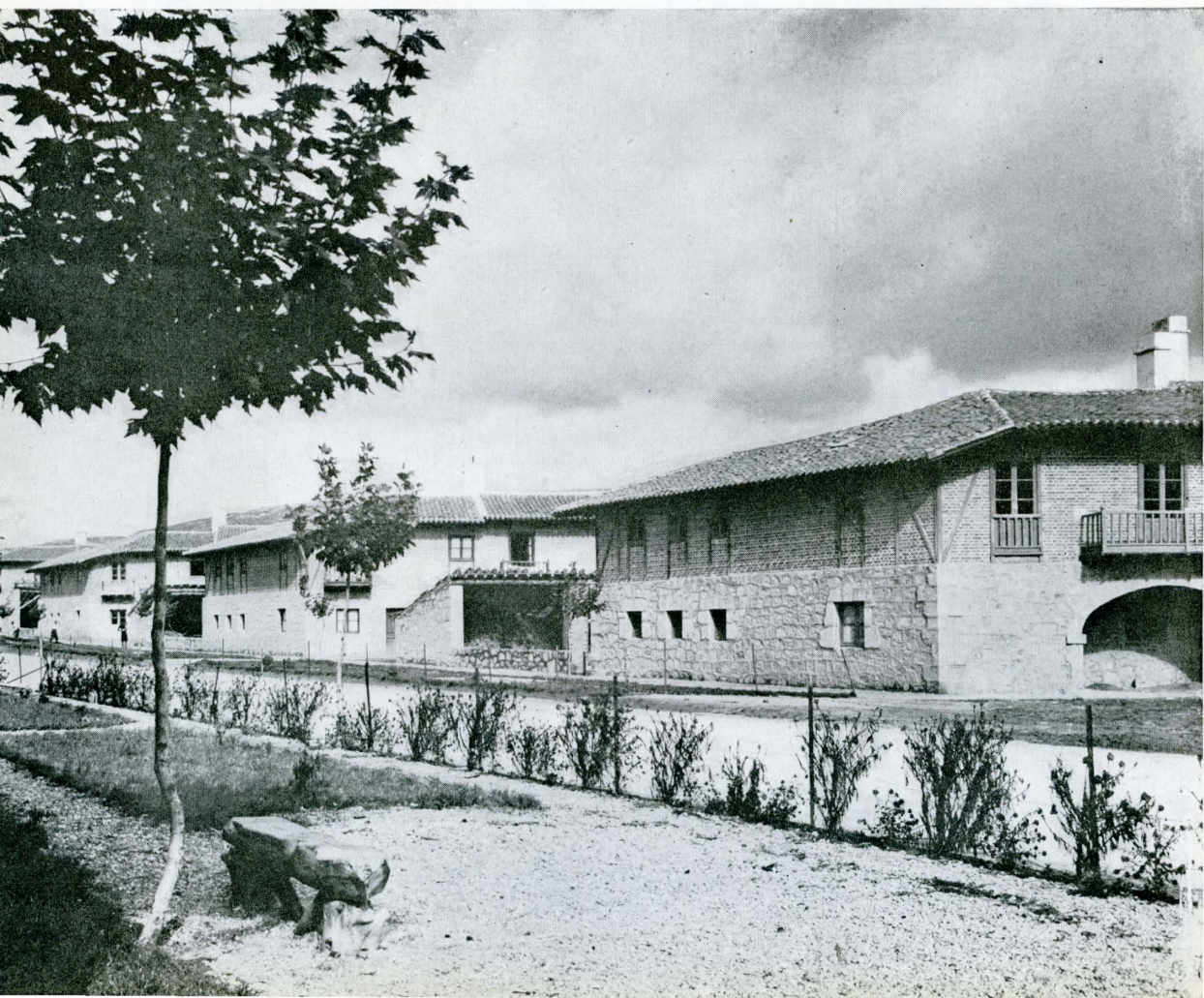
Vista desde la carretera.
