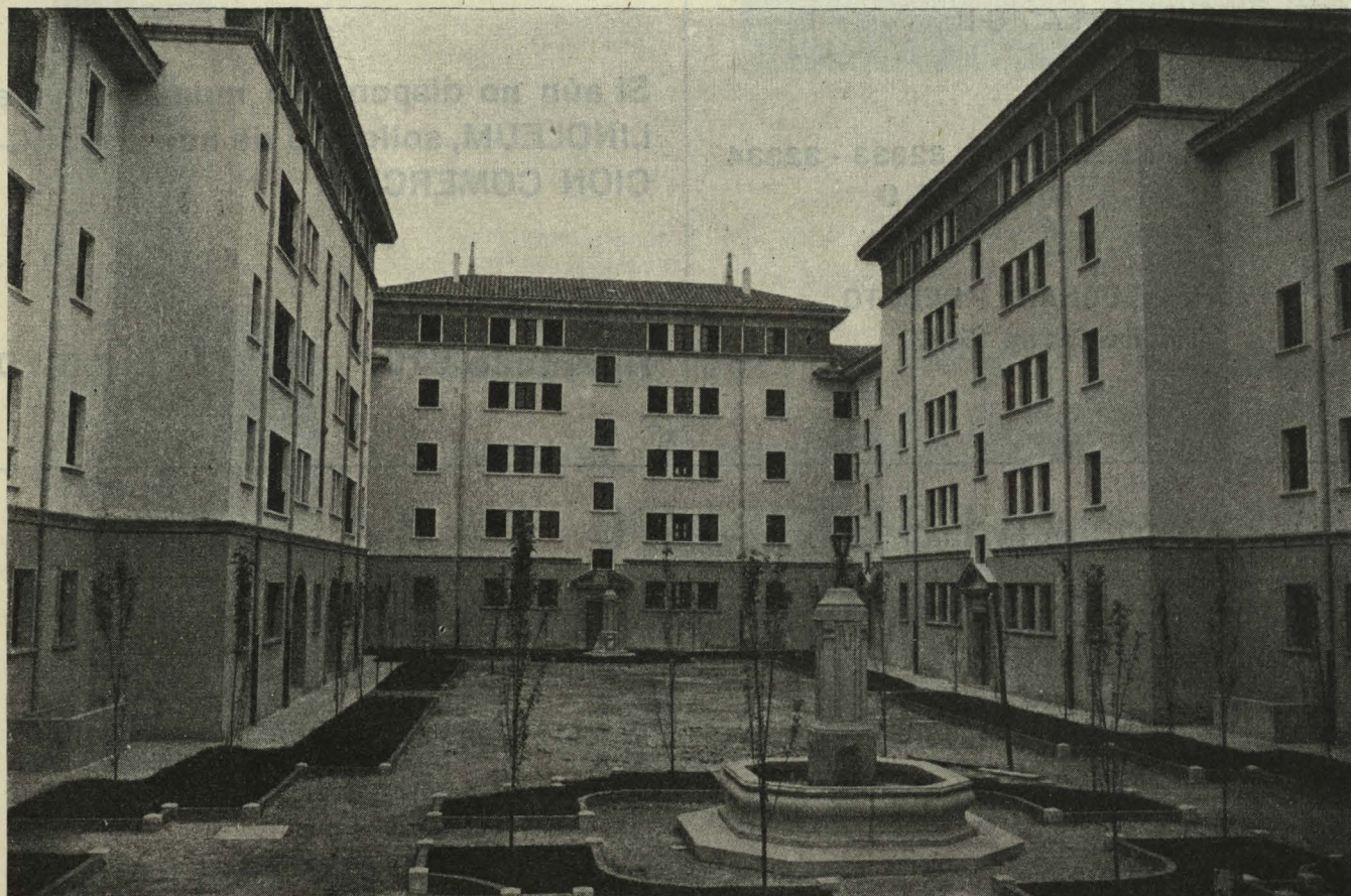
Obras para el Excmo. Ayuntamiento de Gijón
