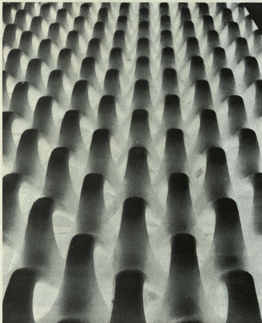
Pared de elementos de hormigón sobre los huecos de fachada para iluminación de la capilla baja.
