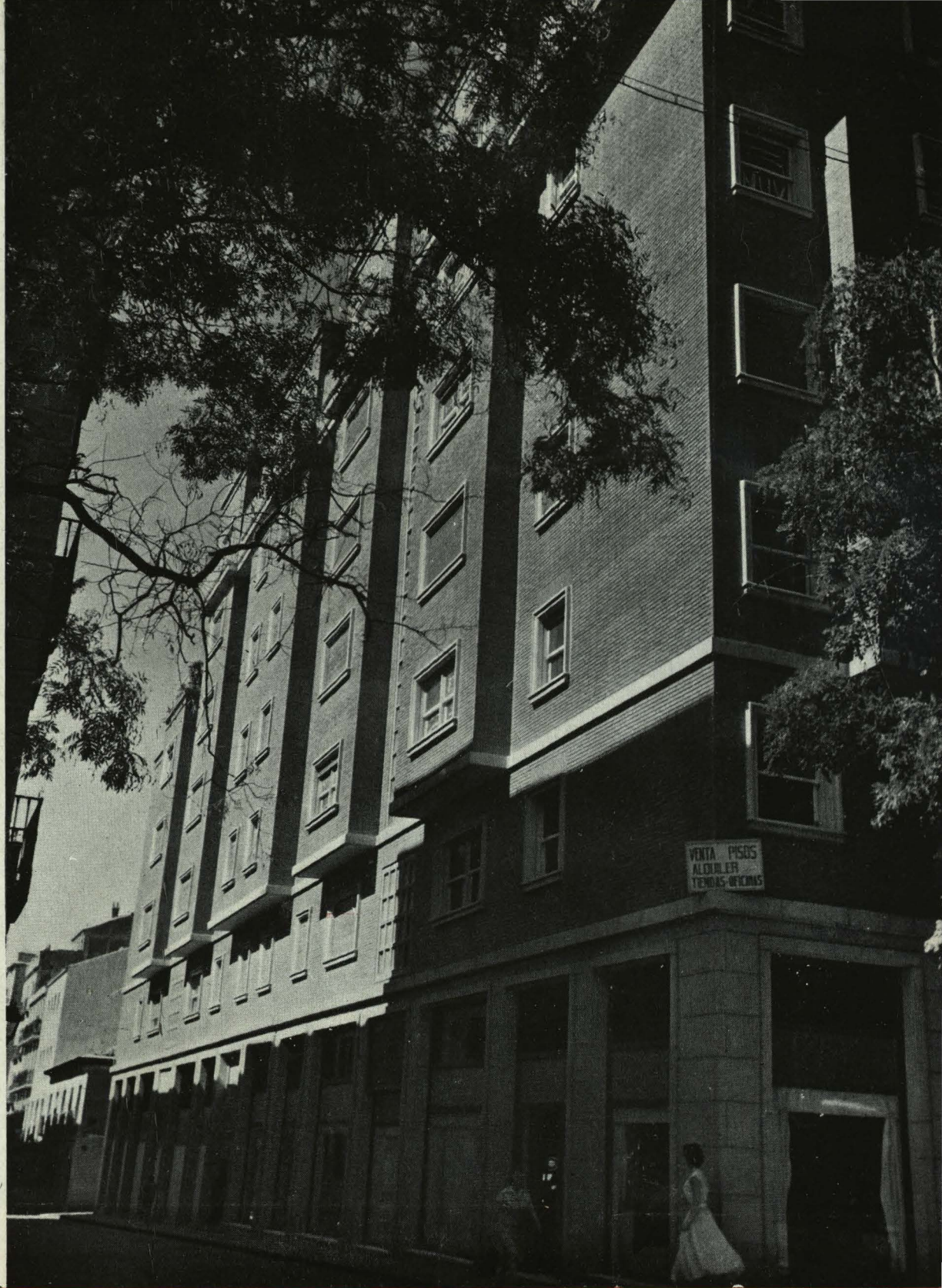
Edificio de viviendas. Madrid. Arquitecto: D. Ramón Escudero Echevarría.
