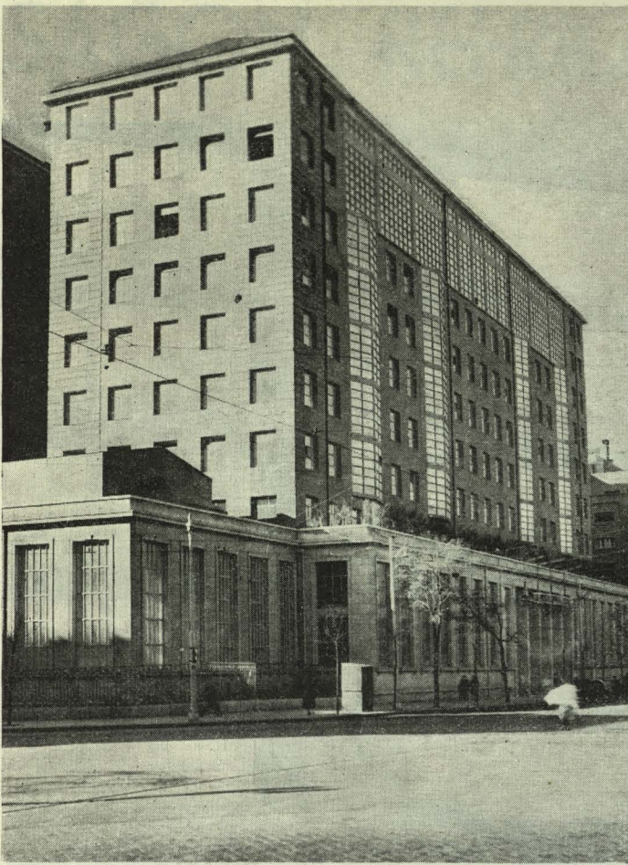
Majestuosa vista exterior del Gran Hospital de la Beneficencia General del Estado, donde puede observarse la solidez y bella armonía de los ventanales "BEIN" de hormigón vibrado. (Foto Portillo)
