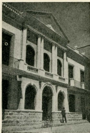
Fachada del Ayuntamiento de Valdepeñas
