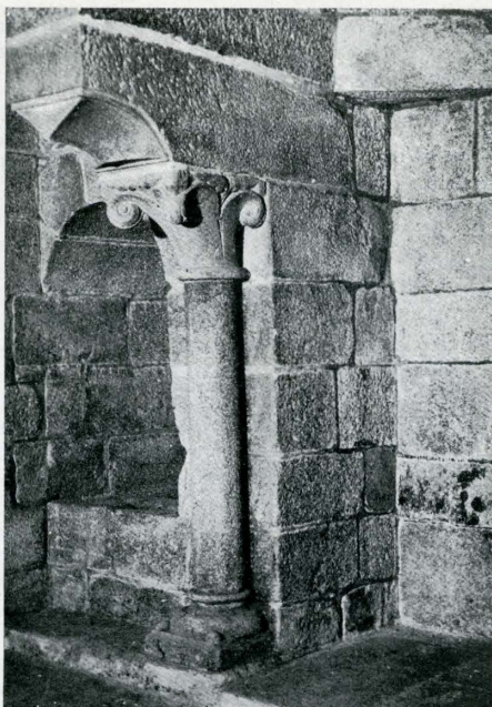
Detalle de la cocina románica del palacio de Gelmir con las soluciones de apoyo de campana. A la izquierda, el nicho correspondiente al pozo de agua potable.
