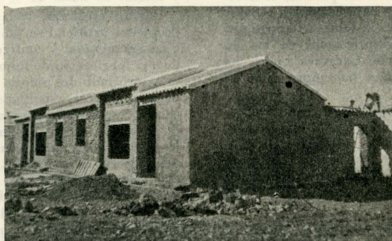
Viviendas para dos guardas del Instituto Laboral durante su construcción
