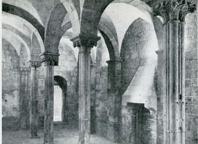
El salón restaurado mirando hacia el Norte. Al fondo, la puerta de acceso desde el "Arco de Palacio".
