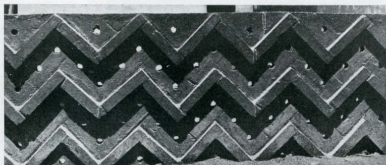
Distintos pormenores del pabellón de Pontevedra.
