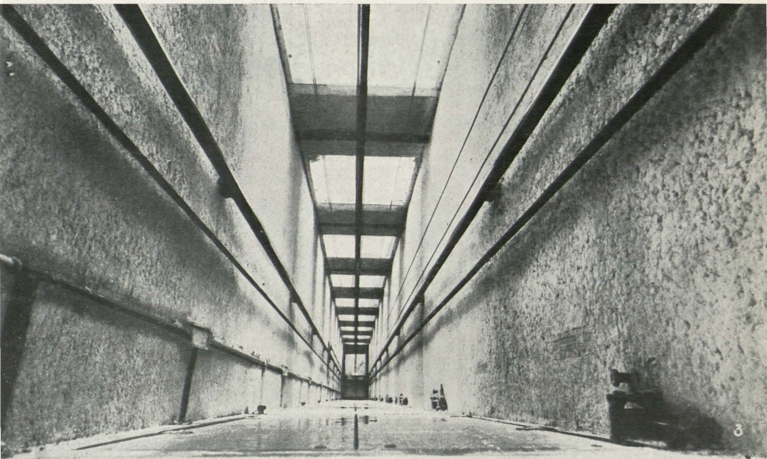
PROTECCION IGNIFUGA Y FONICA Y ANTIVIBRATORIA EN UNA CAJA DE ASCENSORES
