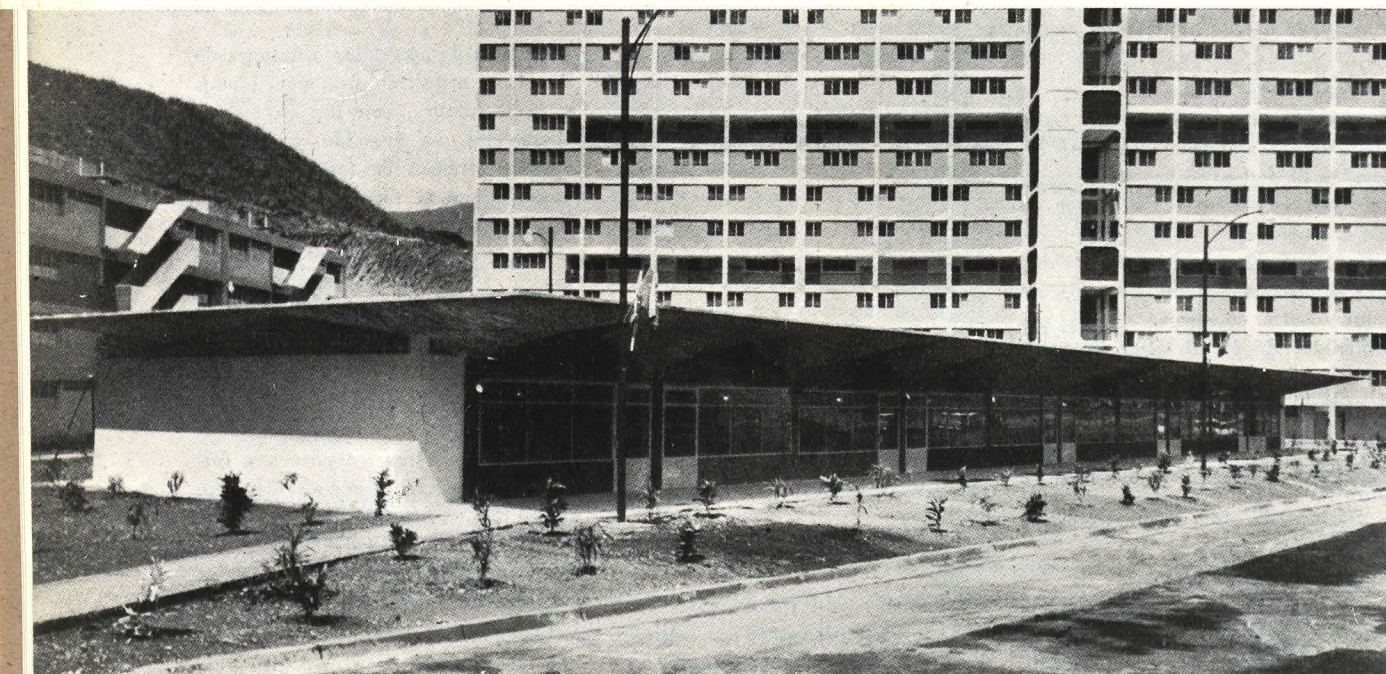
Locales de comercio terminados, con la gran visera protectora de 3,50 metros, cuyo espesor de hormigón es de cuatro centímetros.
