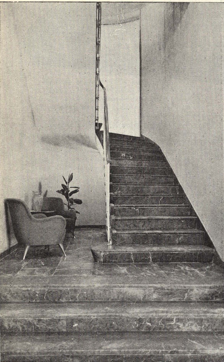
Tramo de escalera principal construída por esta Firma
