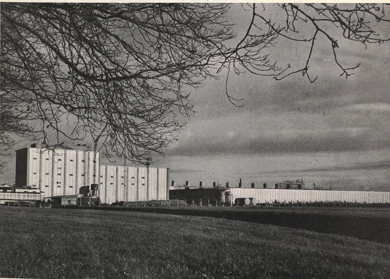
Factoría Seda Holandesa de A. K. U. A. G. en Emmen (Holanda) Tipos de piezas DURISOL empleadas; 7.000 m 2 de placas auto- portantes en cubiertas; 5.000 m 2 de placas prefabricadas de fachada.
