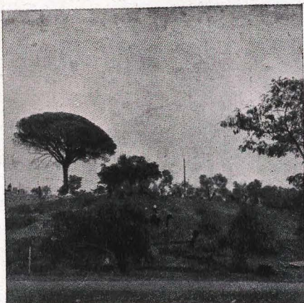
El terreno antes de comenzar la construcción.
