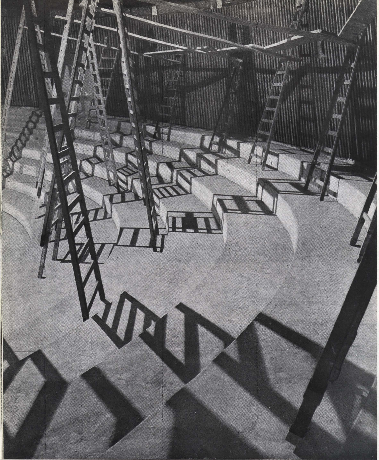
Vista parcial del Teatro de Cámara.
