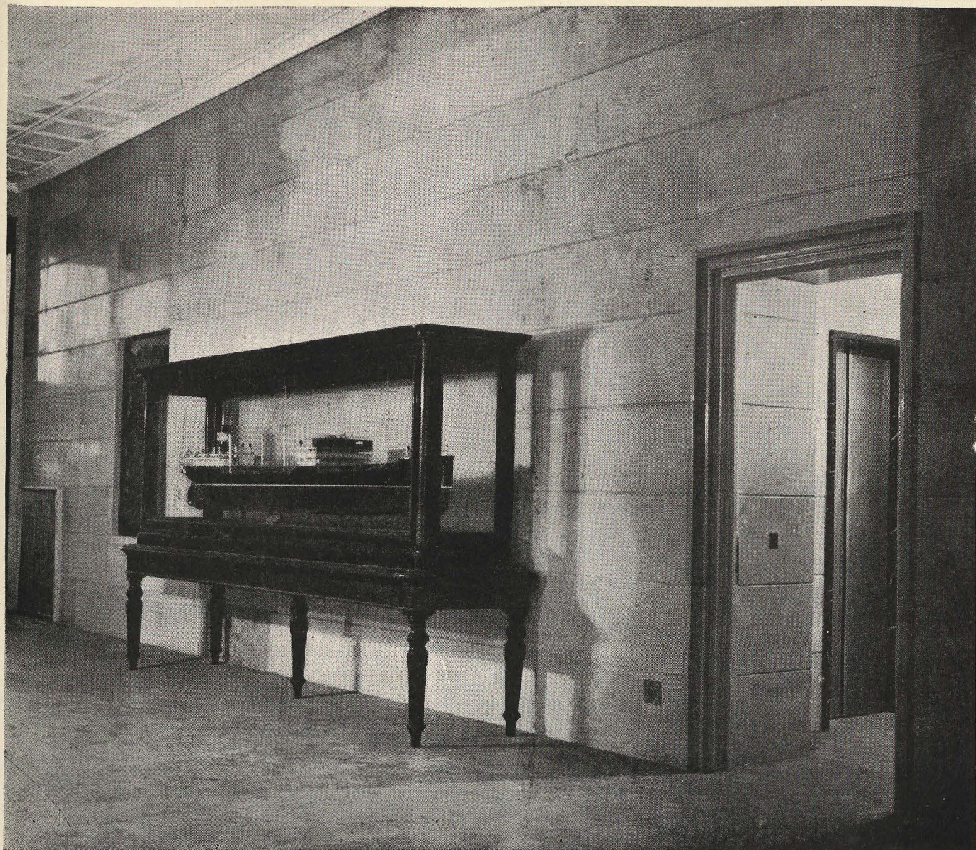
Hall chapado de piedra de Colmenar y recercado de mármol gris arratia.
