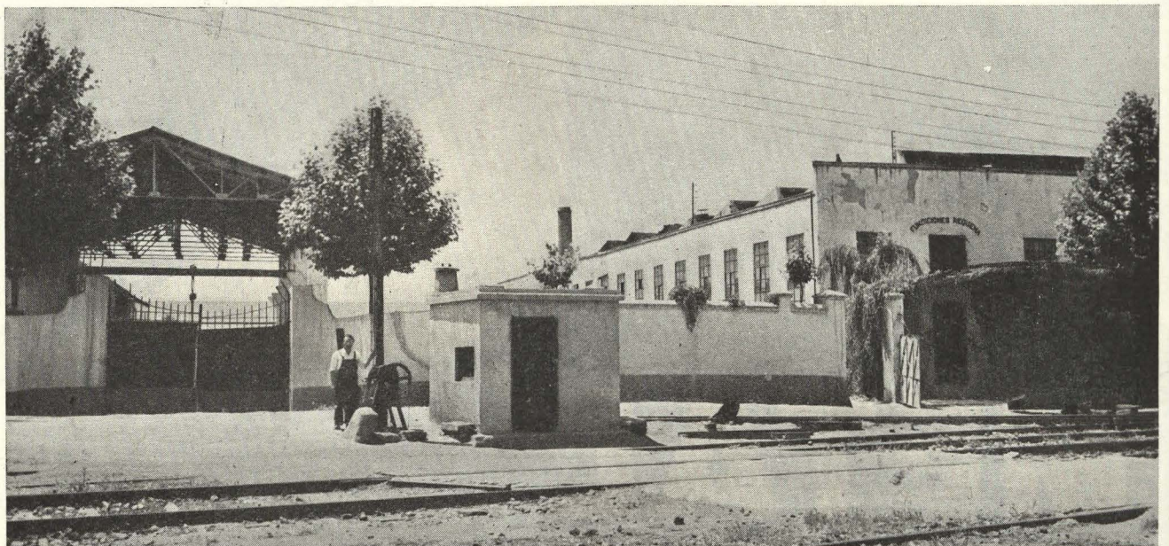
Vista general de la factoría de Meneses, n.º 2. - A la izquierda, las obras de ampliación de la nave de mecanización y laminación.
