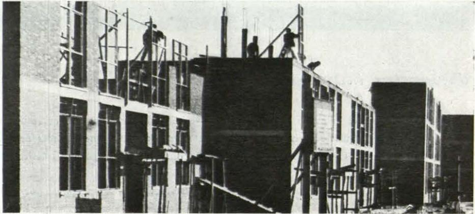
piezas. Enrasadas las fábricas con los ventanales, se hace el segundo forjado, rematado con un zuncho de hormigón que luego se enfosca. De esta manera los cercos quedan perfectamente sujetos a la fábrica; no hay piezas rotas y se eliminan trabajos posteriores de terminado de la fachada.
