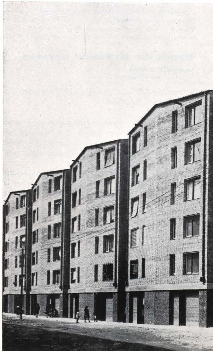
lido de cofre y hormigón abujardado, bajantes de cerámica barnizada, cubierta a cuatro vertientes con teja árabe y "tortugada" (canal de tejado, utilizado frecuentemente en la arquitectura popular catalana y construido con piezas cerámicas parecidas a una teja con aleta), celosía de ladrillo en los tendederos, ventanas de madera con postigos. Las ventanas de las estaciones llevan un postigo vertical independiente para ventilación.
