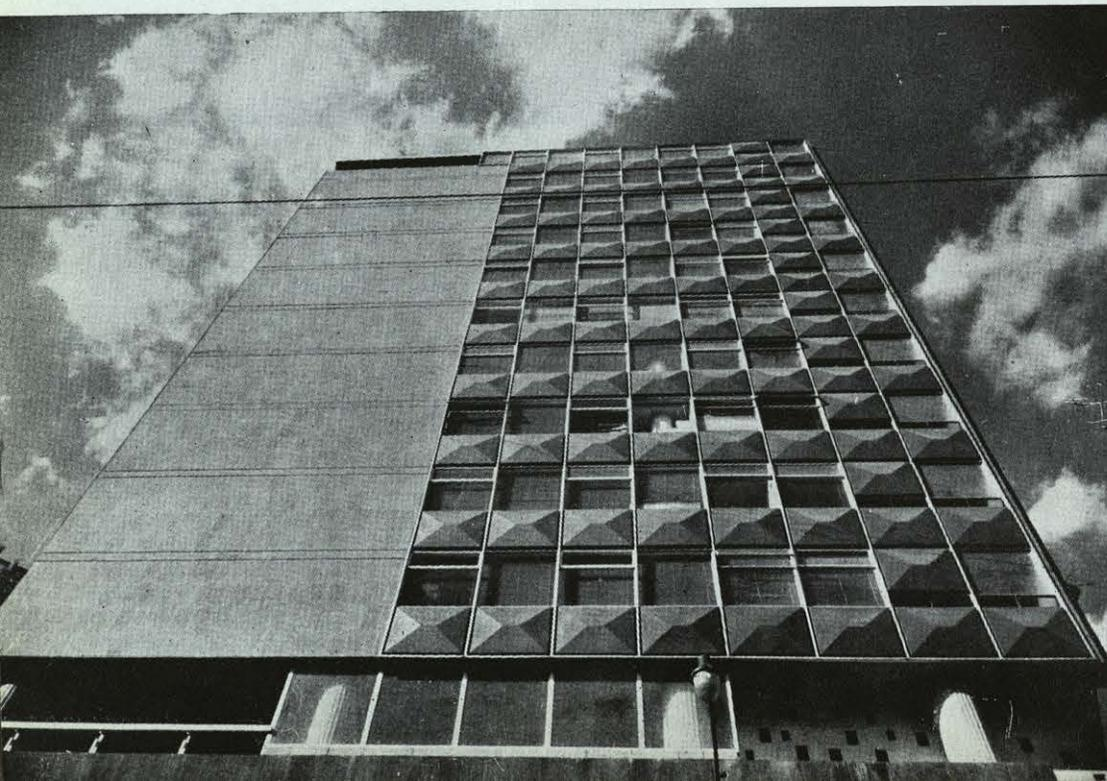
Se aprecian los elementos de aluminio anodizado con que está construida en su totalidad la fachada del edificio. Los elementos verticales continuos tienen los dispositivos de tipo de amortiguador para movimientos sísmicos.
